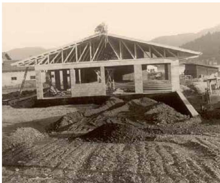
**1968** Herbert ist in seinem Element, es werden bereits die ersten Fachwerkträger mit verdeckt eingebauten Knotenblechen produziert. Kurz darauf verlassen die ersten Leimbinder die Produktionshalle.
