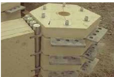
Der Knoten mit einem Stabanschluss mit den Steckbolzen und BSB-Knotenblechen in den Stäben
